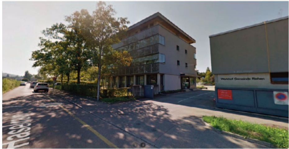
Energiezentrale in Riehen zur Weiterleitung an das Fernwärmenetz
